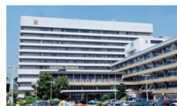
② 2号館 Building 2
